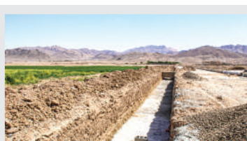
کانال دفع آب های سطحی خیابان نواب صفوی
