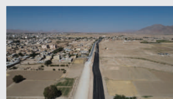
اتمام عملیات آسفالت بلوار سلمان فارسی
