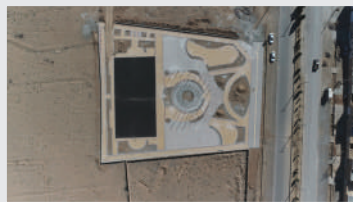
احداث پارک محله ای بلوار شهید منتظری
